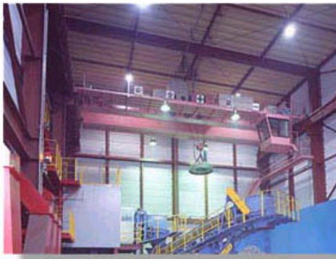
図 1.3: 天井走行クレーン
