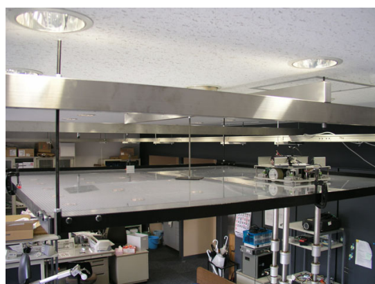
図 3.84: RR3内に設置されたロボット動作用天井(天井裏支持部)
