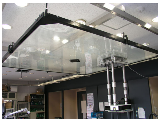
図 3.83: RR3内に設置されたロボット動作用天井(下面より)
